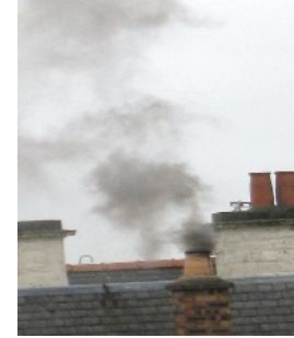
Chauffage logements & bureaux
