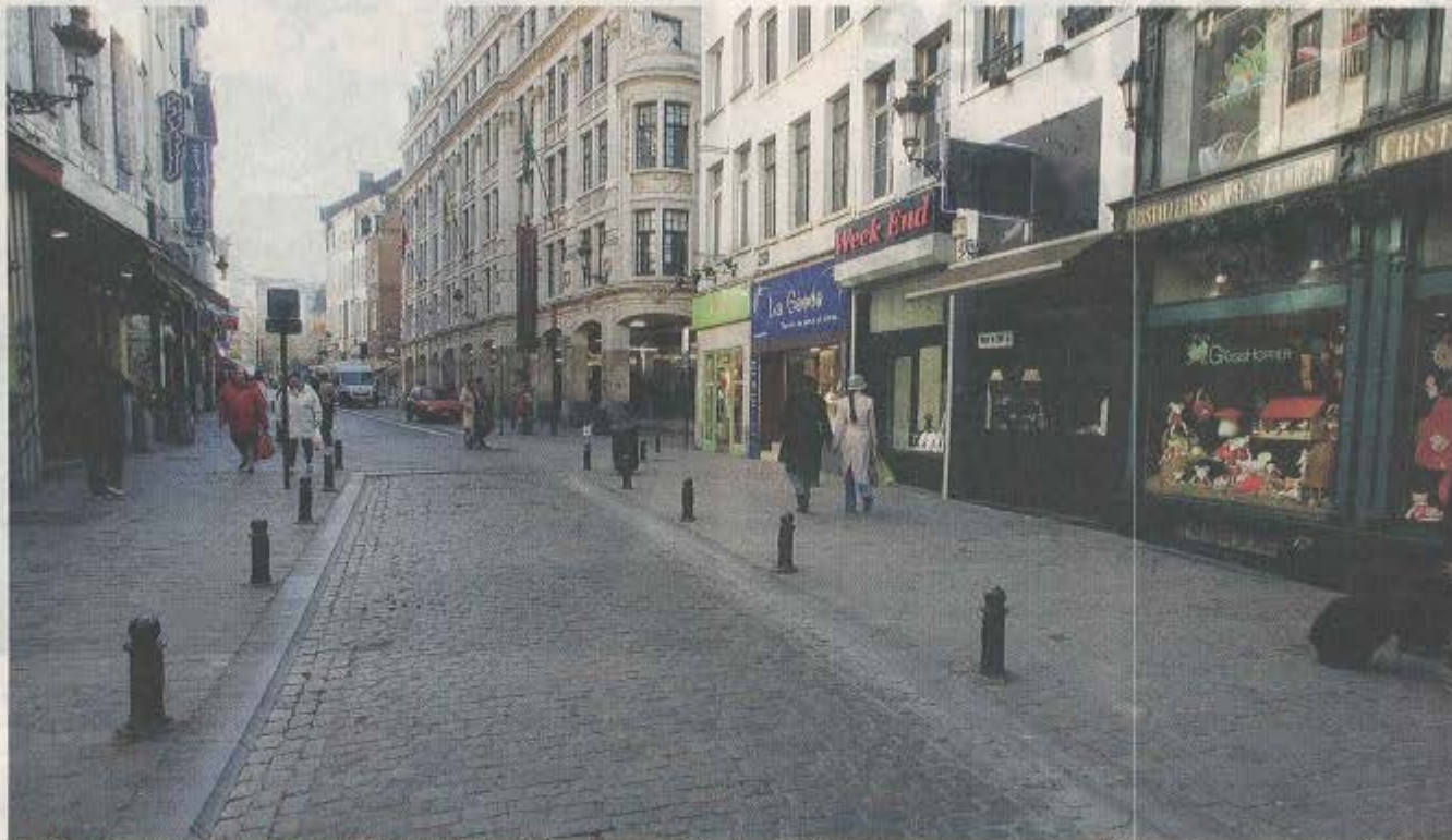
LE PIÉTONNIER DE LA RUE MARCHÉ AUX HERBES a engendré l'insécurité. Les commerces neufs ne tiennent pas un an, indique le mémorandum remis à la Ville. © ALAIN DEWEZ.
