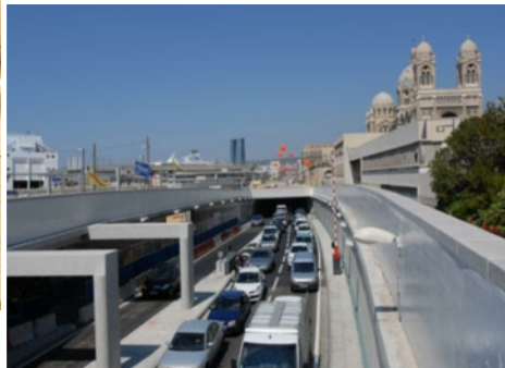
Tunnel de la Joliette inauguré en 2011 à Marseille
